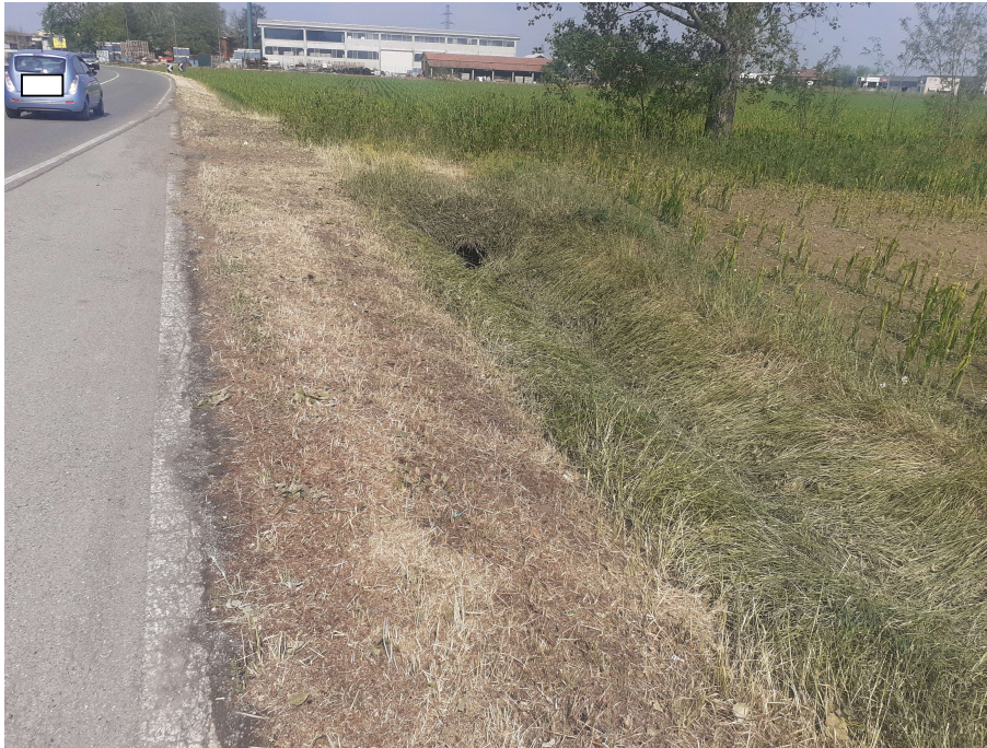
Figura 8-1. Zona di ingresso, strada provinciale SP99.
