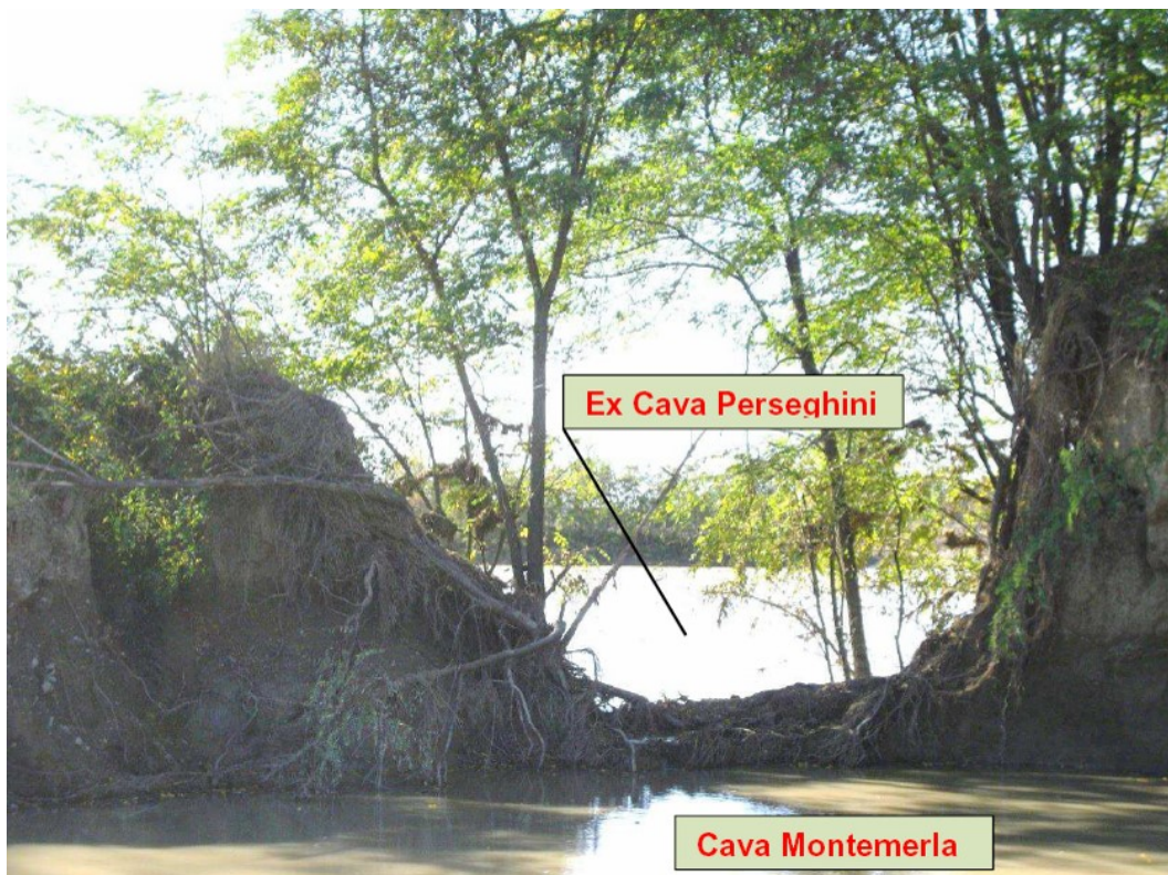
Figura A- 5. Ripresa della breccia che si è formata, a seguito del sormonto della lama d'acqua sul coronamento della struttura, nel setto divisorio tra la ex cava Perseghini (sullo sfondo) e cava Montemerla (tratto da BARBIERI D.-2014).
