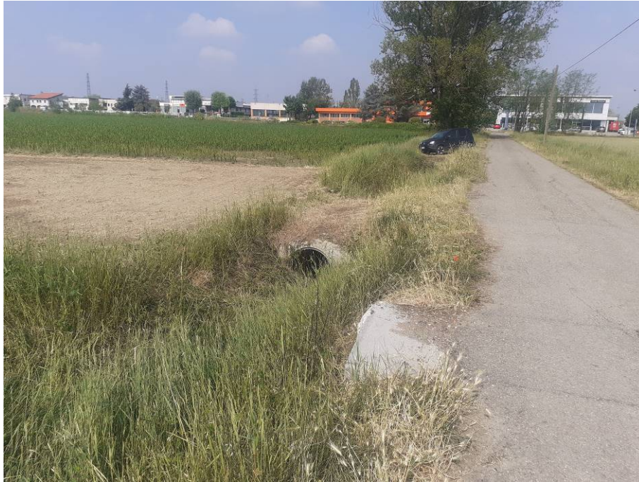
Figura 10-3. Strada Montemerla vista in direzione della SR10.
