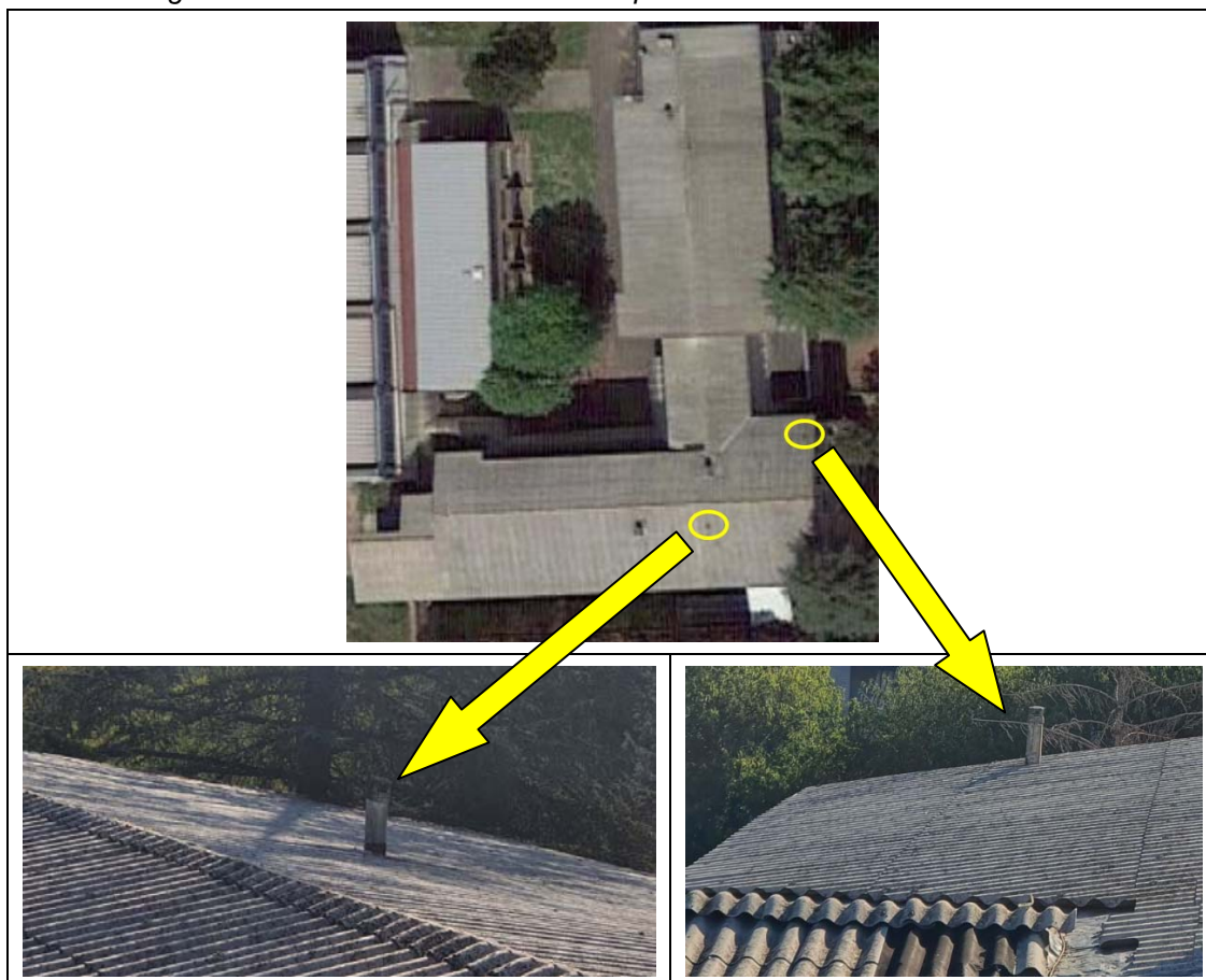
Figura 12: Foto aerea con indicazione posizione sfiati in cemento-amianto
