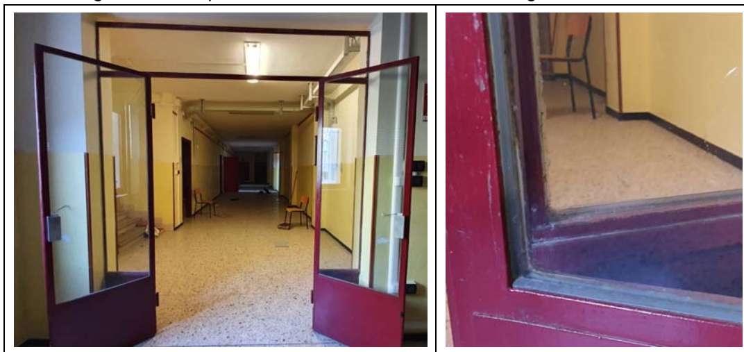
Figura 22: Foto porte a vetri interne all'Edificio A con sigillature in silicone
