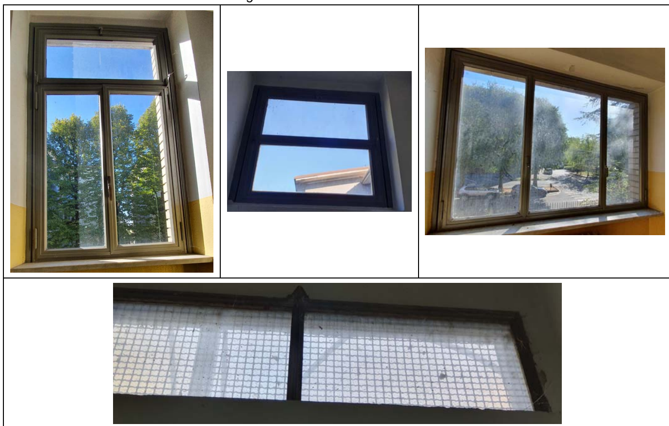
Figura 21: Finestre Edificio B
