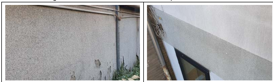
Figura 24: Foto rivestimento esterno su parte dell'Edificio A
