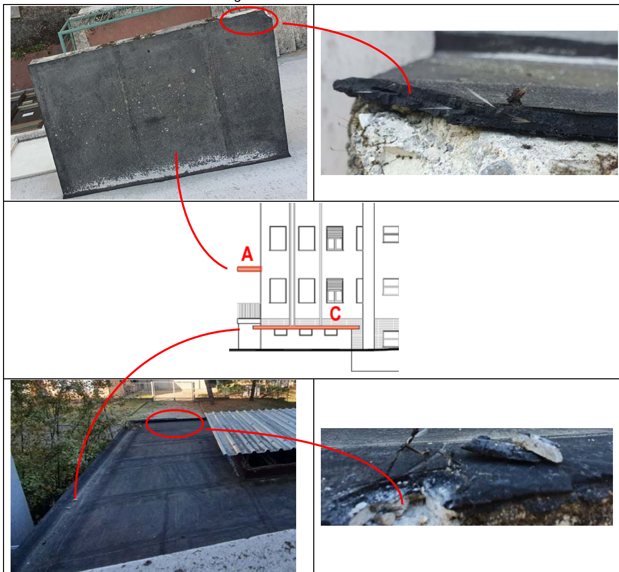
Figura 17: Guaine bituminose A e C
