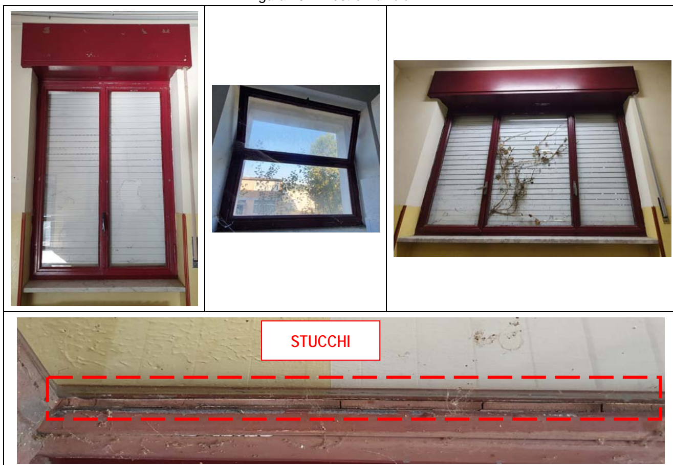
Figura 20: Finestre Edificio A
