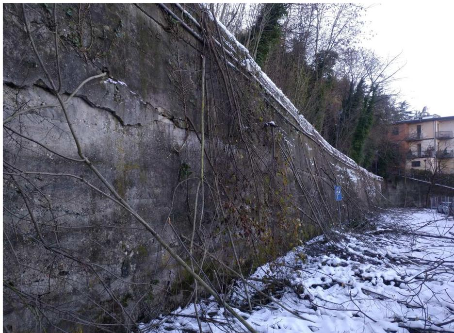
Il progetto esecutivo prevede la realizzazione di un muro di sostegno in cemento armato, a ridosso del muro esistente, formato da una parete verticale, una travatura di fondazione con annessi pali trivellati, la ristrutturazione di una parte del muro esistente e l'inserimento di tiranti geotecnici di ancoraggio.
