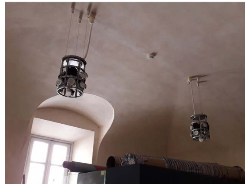
RIQUALIFICAZIONE FUNZIONALE CORPI ILLUMINANTI ESISTENTI CON SOSTITUZIONE PARABOLA CON LAMPADINE CON PARABOLA CON LAMPADINE LED
