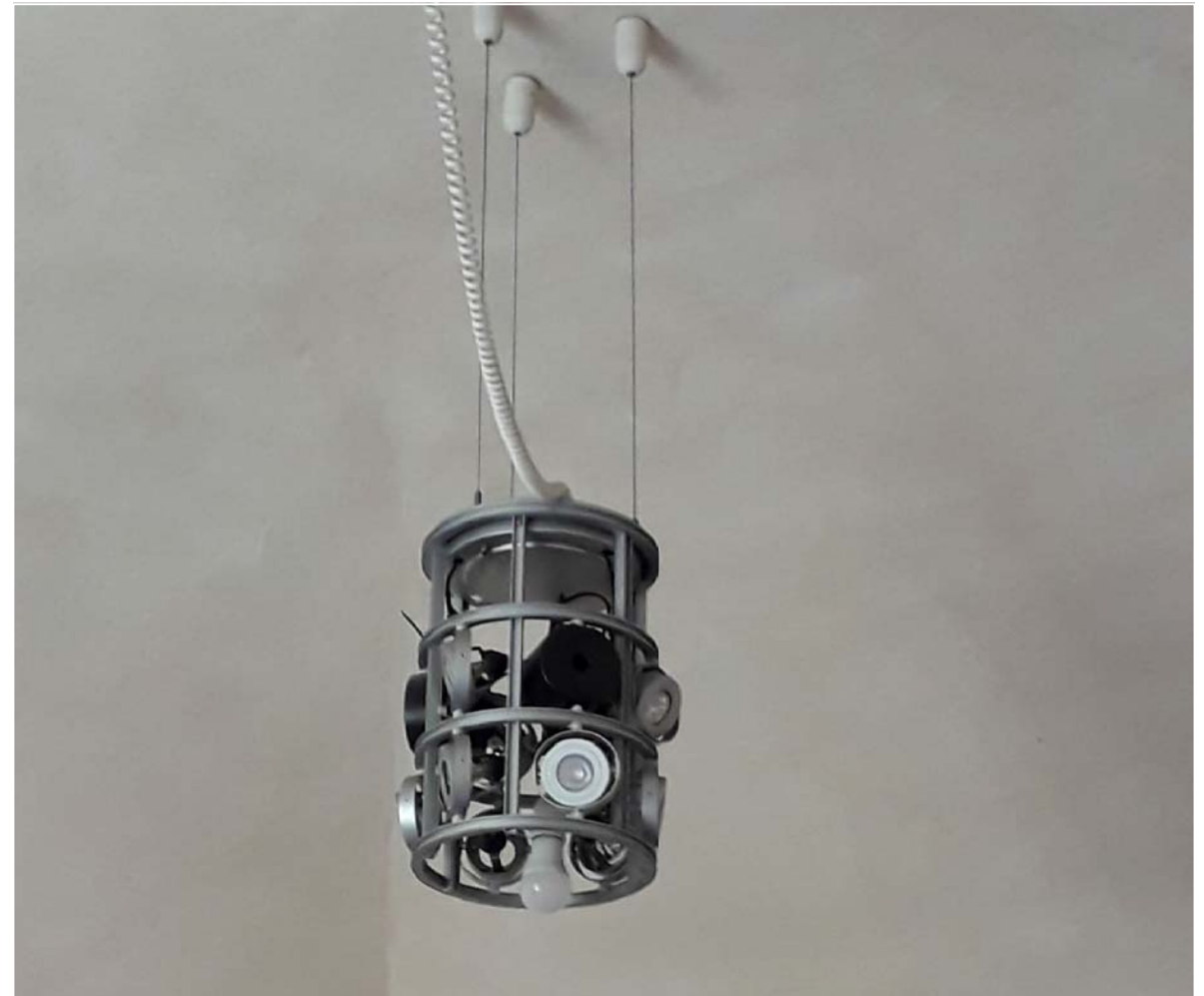
RIQUALIFICAZIONE FUNZIONALE CORPI ILLUMINANTI ESISTENTI CON SOSTITUZIONE PARABOLA CON LAMPADINE CON PARABOLA CON LAMPADINE LED
