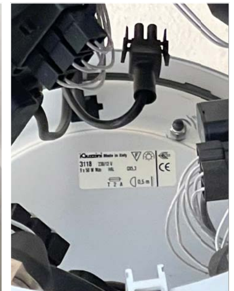
RIQUALIFICAZIONE FUNZIONALE CORPI ILLUMINANTI ESISTENTI CON SOSTITUZIONE PARABOLA CON LAMPADINE CON PARABOLA CON LAMPADINE LED
