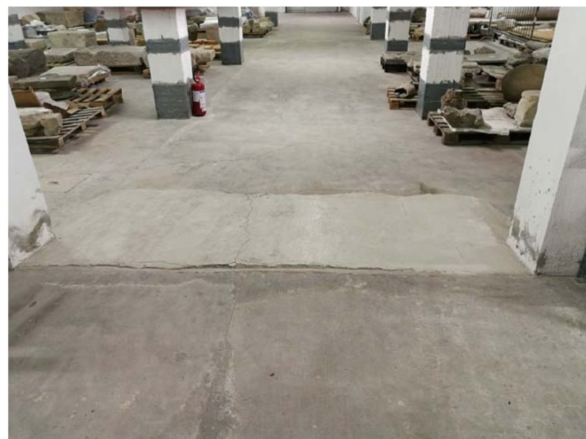
Smantellamento e rifacimento rampa di collegamento delle due quote dei pavimenti delle sale
