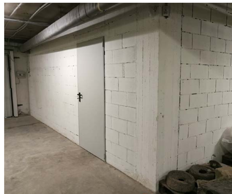
Realizzazione intonaco e tinteggiatura
