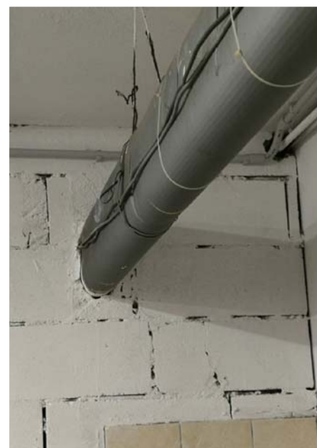
Foderatura tubazioni impianto termico con realizzazione cassonetto in cartongesso
