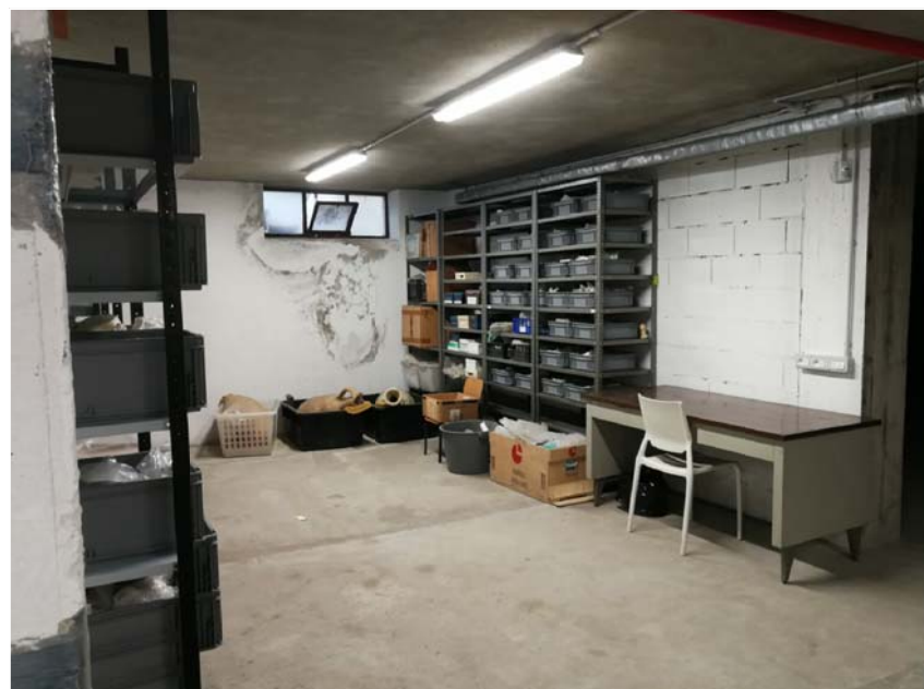
Spicconatura e rifacimento intonaco e tinteggiatura
