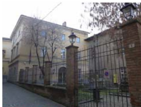
PALAZZO GUIDOBONO E CANTIERO ARCHEOLOGICO
