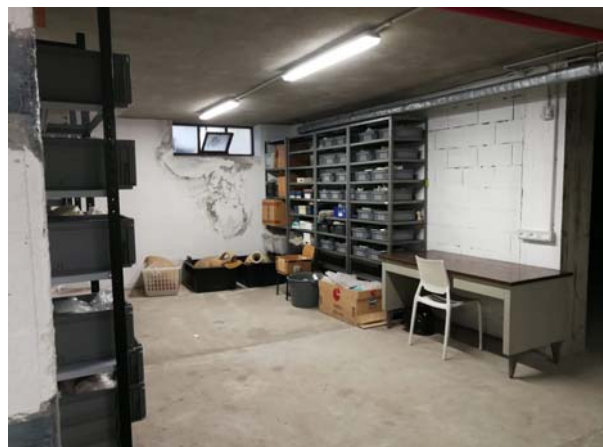
Situazione degli intonaci da risanare nelle aree allestite con scaffali metallici e reperti entro cassette.
