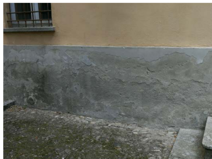
Spicconatura per tutta l'altezza dello zoccolo (cm. 110) e rifacimento con intonaco di tipo deumidificante.
