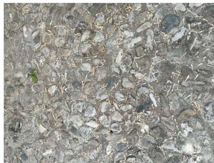
Perfetta pulizia mediante idropulitrice e spazzolatura manuale della pavimentazione in ciottoli di pietra, cordoli in pietra e aree perimetrali ai reperti archeologici in ghiaietto e cemento.
