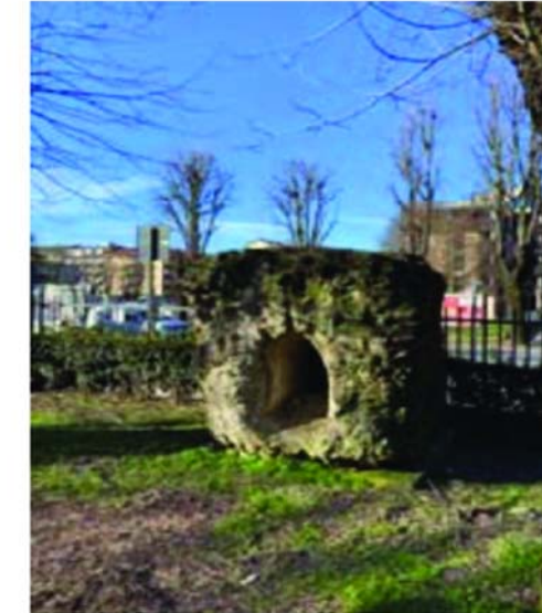
Tratto di acquedotto in muratura 200x180x200
