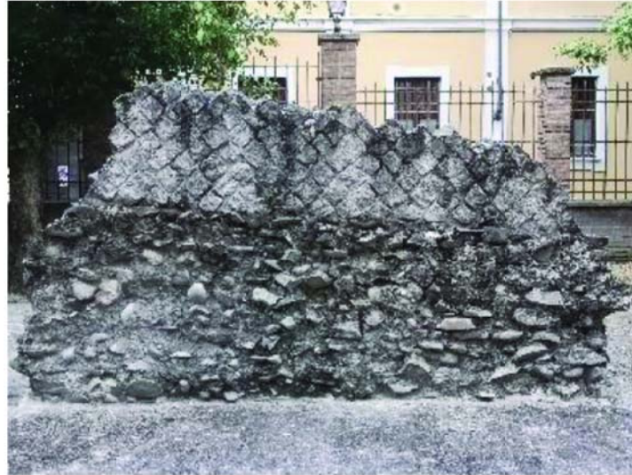
Tratto di muratura in opus reticulatum, da via Ugone Visconti via Di Vittorio 177x341x59 - Età romana
