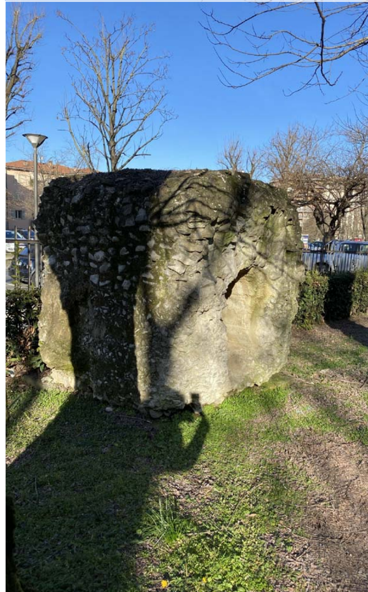
Tratto di acquedotto in muratura di età romana Dim. h. 200x180x200
