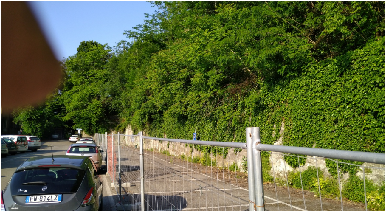
Visuale del muro e dell' area sottostante, attualmente transennata ed interdetta al traffico veicolare
