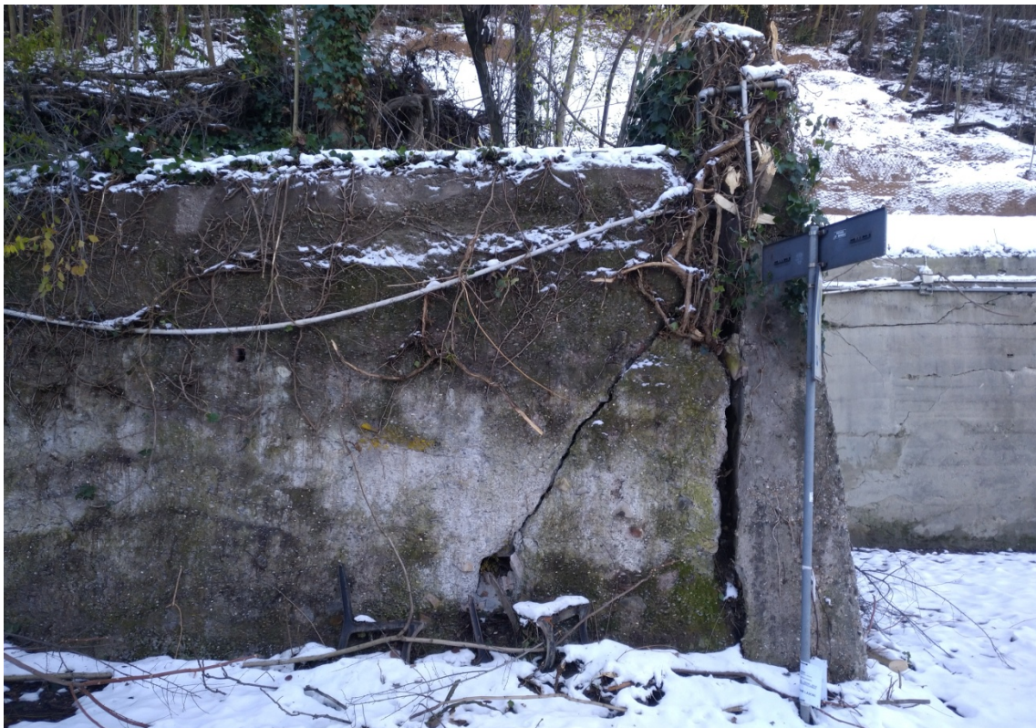
Spalla sinistra e tratto sinistro (H 3,50) verso l' accesso al Parco M.I.
