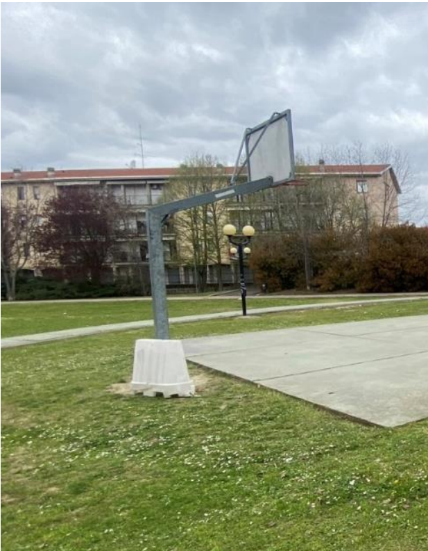
PALO PALLACASTESTRO DA SOSTITUIRE
