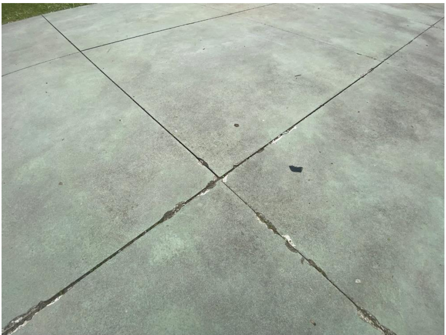
PAVIMENTAZIONE DISCONNESSA
